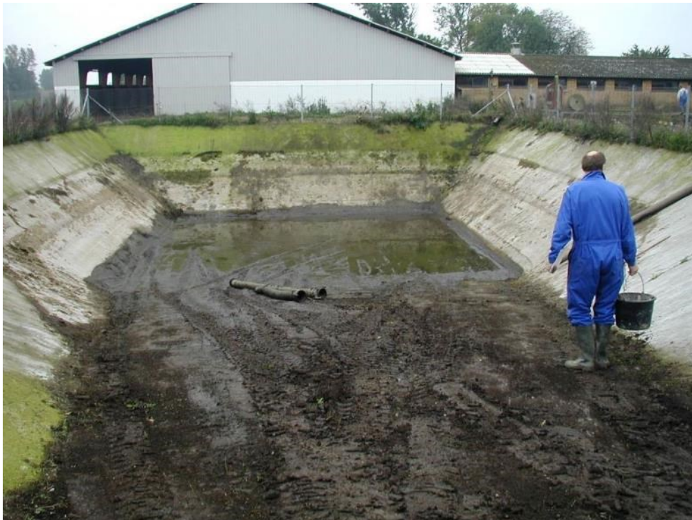
Foto 31: Lagune af fiberbeton.
