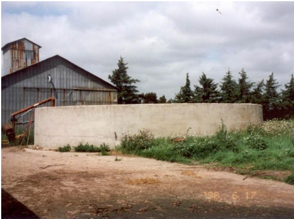
Foto 19: Blokstensbeholder, der er pudset.
