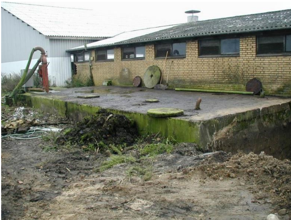
Foto 18: Ajlebeholdere som denne er ofte opbygget af bloksten, der dog ikke er krumme.
