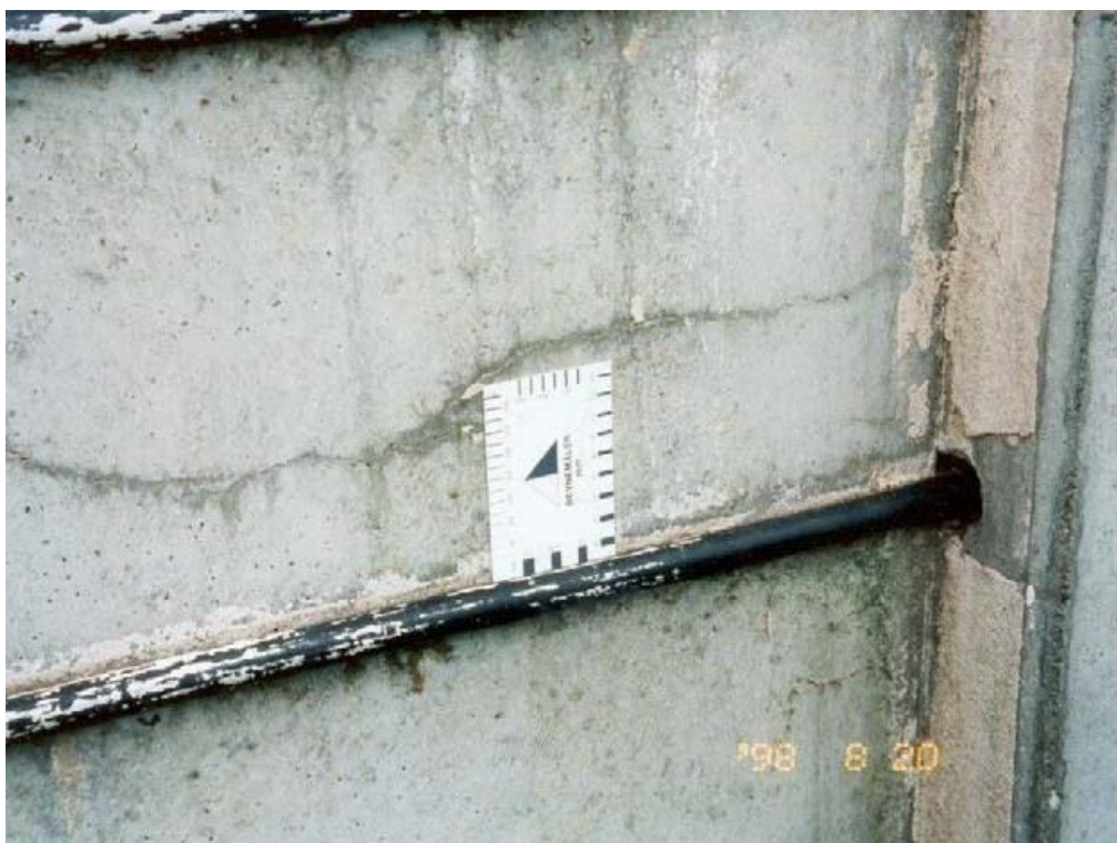
Foto 44: Revner ses ofte i beholdere af beton. Små revner uden gennemsivning af gylle som her er uden betydning.
