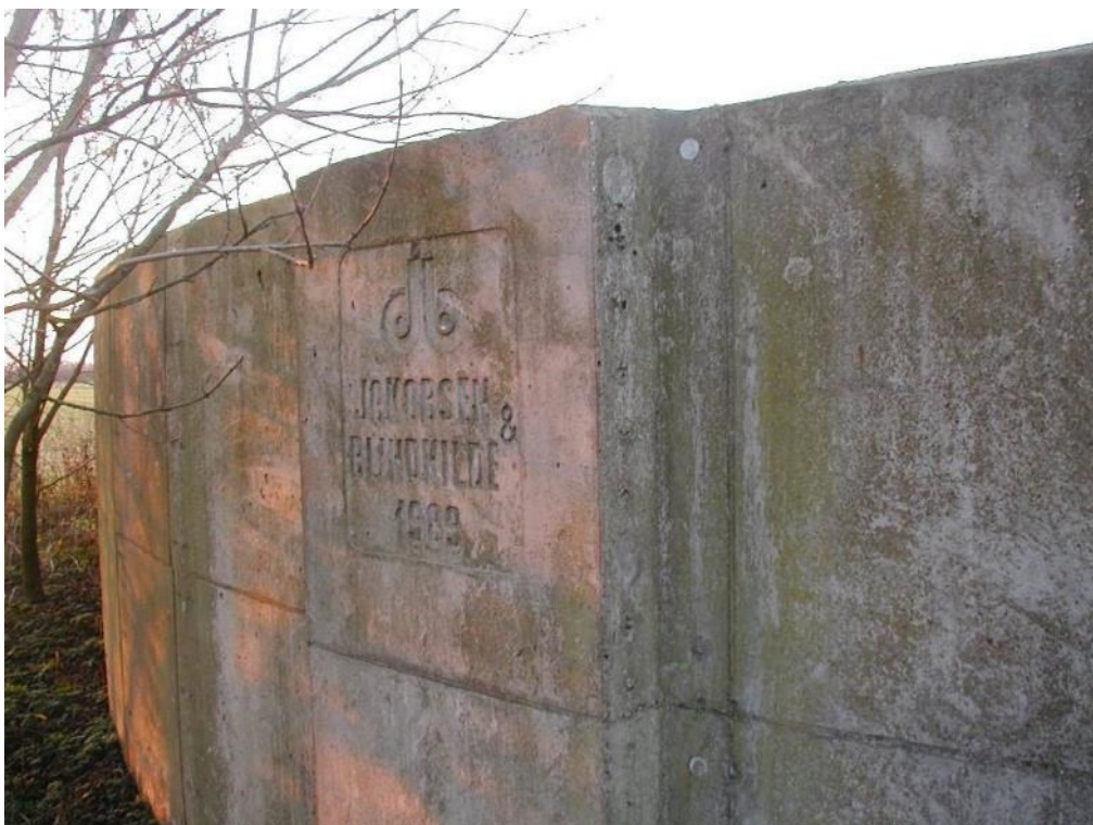
Foto 16: Armeret betonbeholder støbt på stedet.
