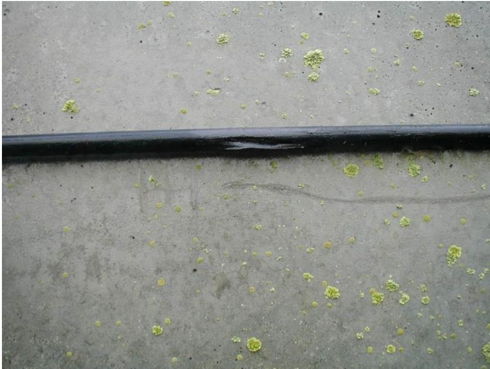
Foto 40: Kabler over terrænen har ofte skader fra påkørsel eller andet.
