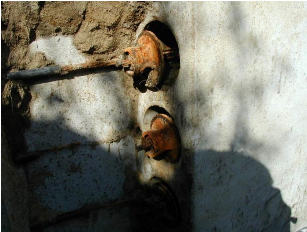
Foto 39: Kabelforankringen er let rusten og en del af kablet (til højre) er ikke beskyttet.
