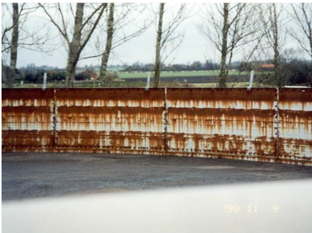
Foto 57: Overfladebeskyttelsen på indersiden af denne stålbeholder er stort set forsvundet og pladerne rustet.
