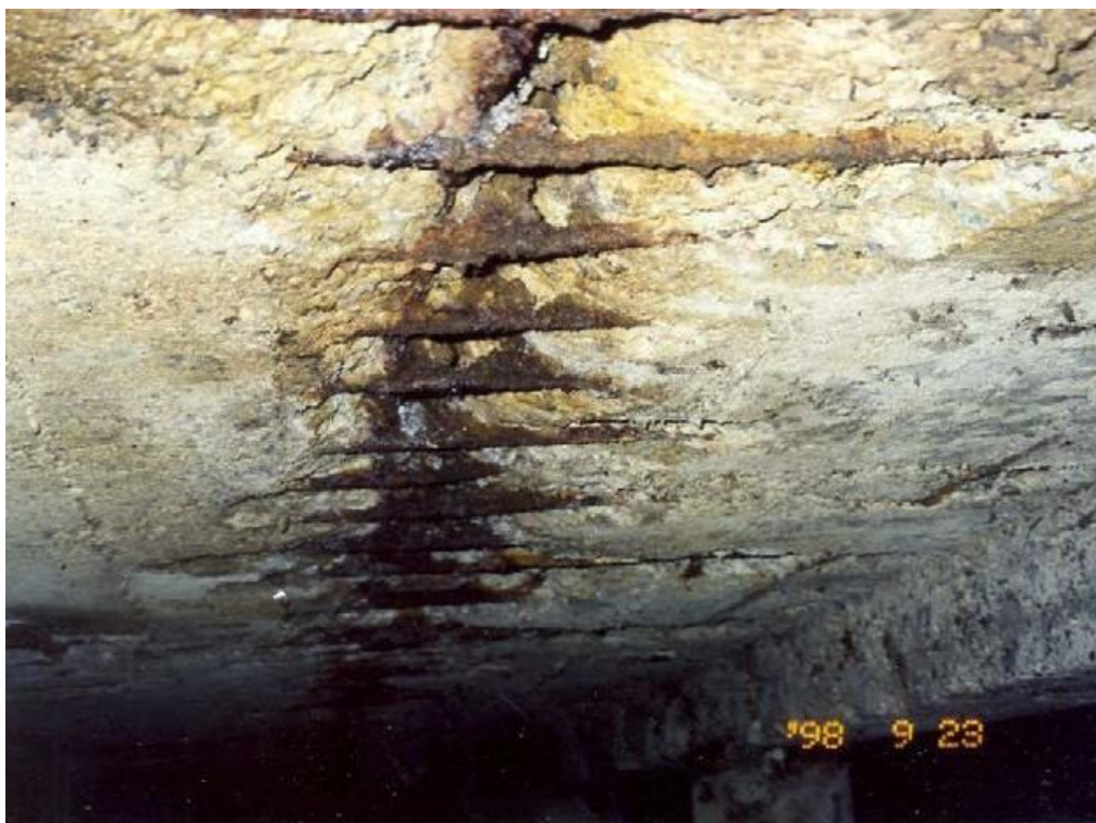
Foto 43: Undersiden af ældre betondæk kan være meget tæret af gyllen som det ses her. Færdsel på et sådant dæk er forbunden med fare for nedstyrtning.
