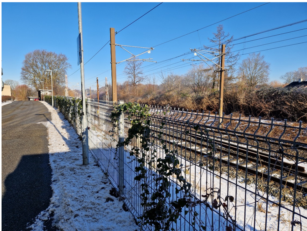
Figur 12-1 Eksempel på eksisterende stålmattehegn, som forhindrer adgang til sporene.
