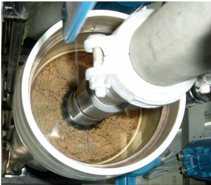
Figur 14.4. Ultrafiltreringsanlæg med hulfibermembraner til behandling af svømmebadsvand
