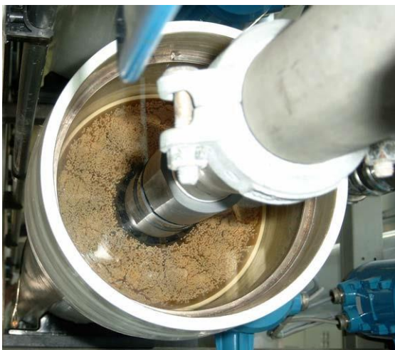
Figur 14.4. Ultrafiltreringsanlæg med hulfibermembraner til behandling af svømmebadsvand
