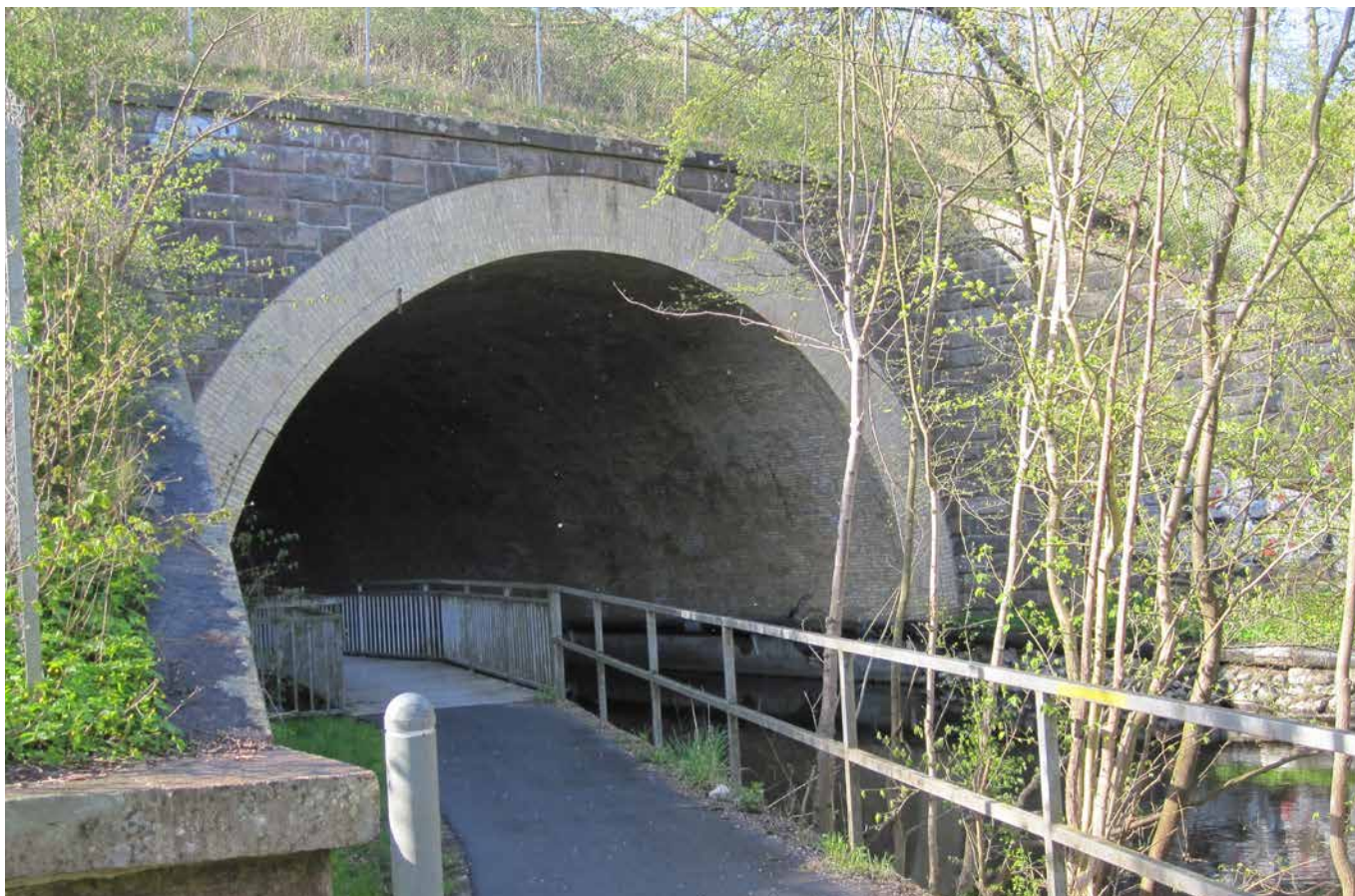
Ringsted Å føres under jernbanen i en tunnel. Her ses den nuværende tunnelmunding med stenkæmning fra stien på den nordlige side mod syd.
