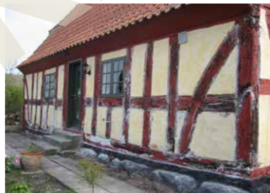
Den tekniske tilstand af dette bindingsværk ses tydeligt, men det var stort set lige så tydeligt at se gennem de store afskalninger, buler og revner, der var synlige før afhugningen af cementreparationerne.
