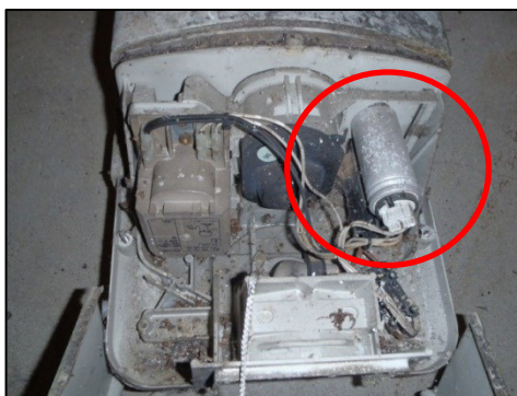
Eksempler på placering af kondensatorerne i lysstofarmaturer (øverst) og armaturer til kviksølvdamplamper og natriumlamper (nederst).
