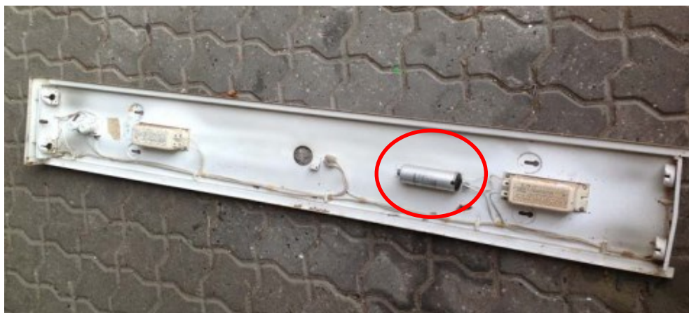
Lysstofarmatur med kondensator (rød cirkel)
